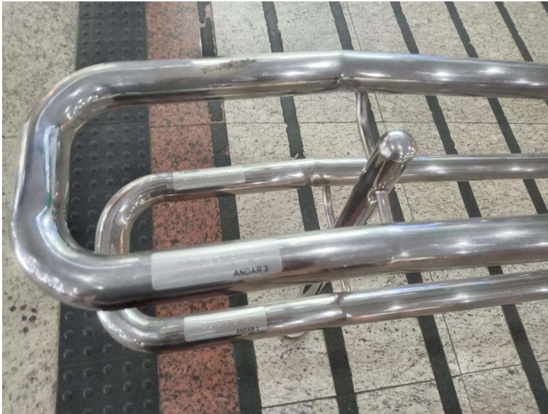
Figura 25. Corrimãos presentes no Terminal Rodoviário de Goiânia
